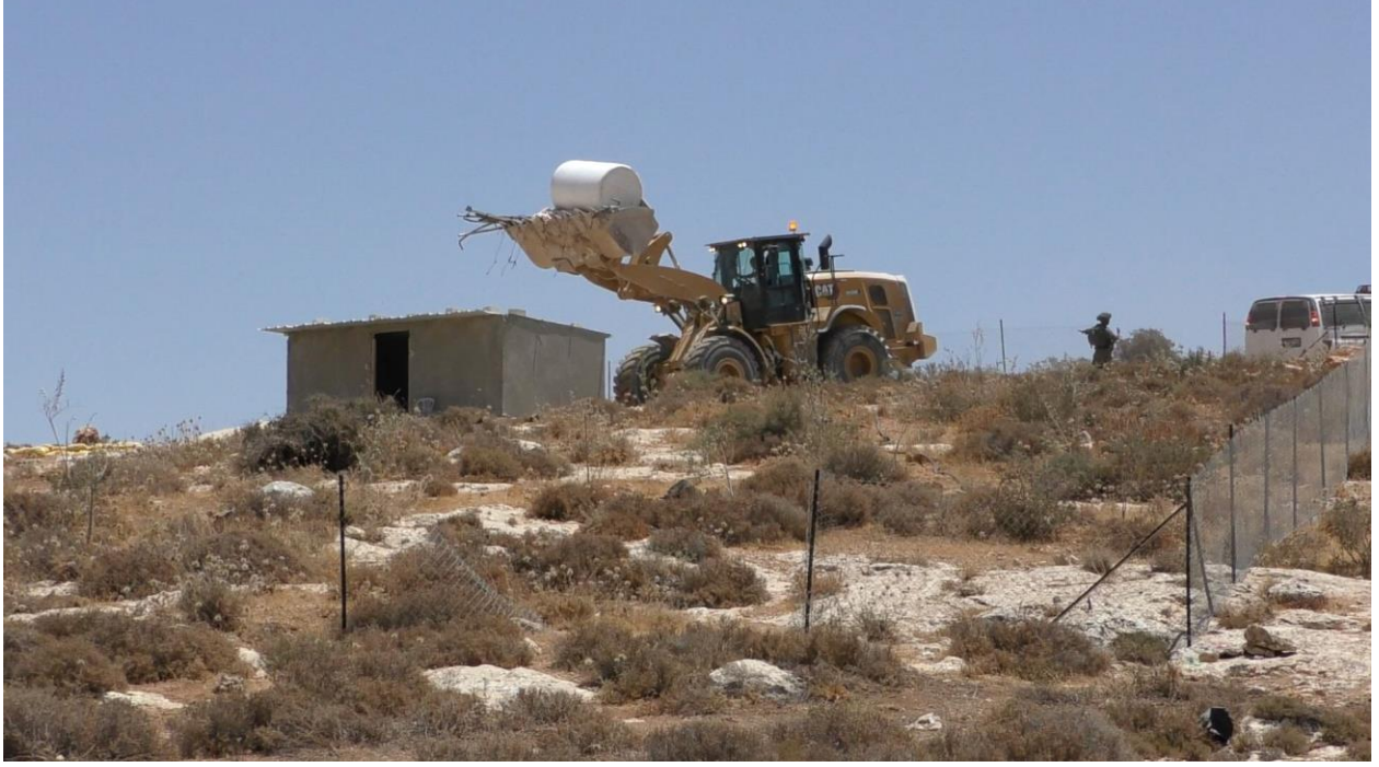
في الصورة: مصادرة خزانات مياه في الجوايا، جنوب شرق بلدة يطا في تلال جنوب الخليل. بتسليم، 19 تموز 2022
